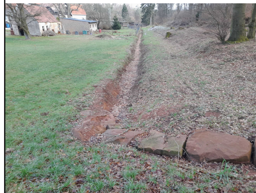
2.5.1.1.1 Weiterführender Graben Einleitpunkt Drosselleitung
