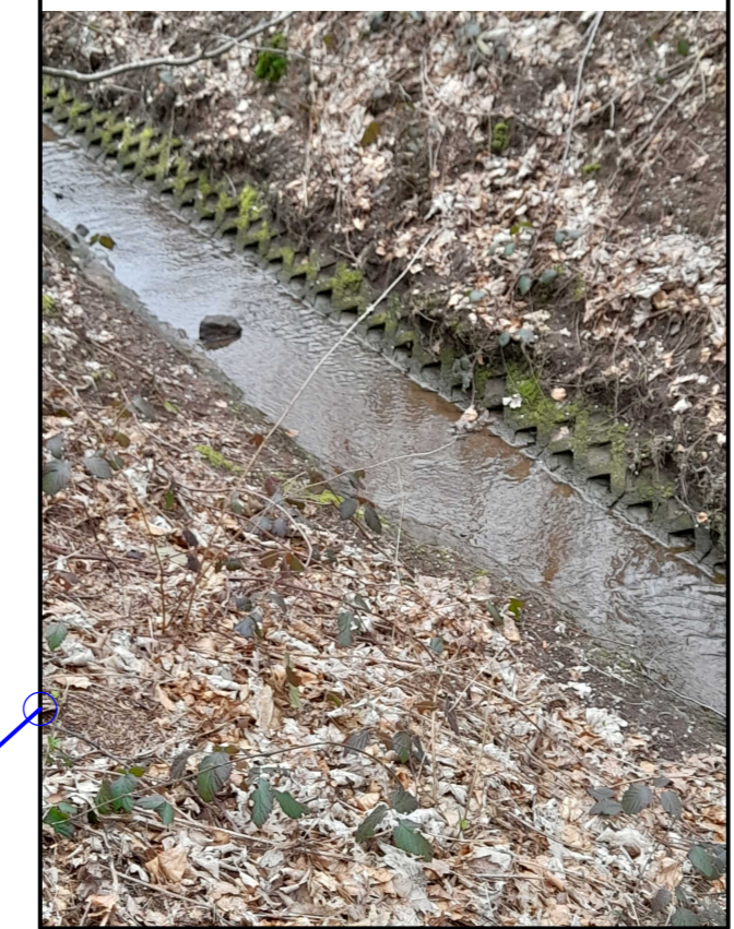
2.5.1.1.3 Graben nach Durchlass unter Autobahn
