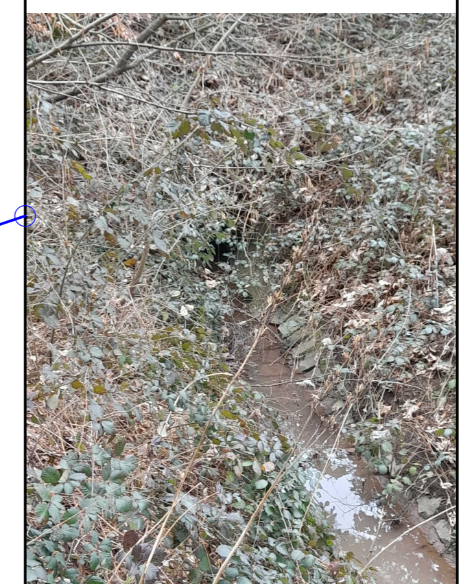
2.5.1.2.2 Durchlass unter Autobahn DN1000
