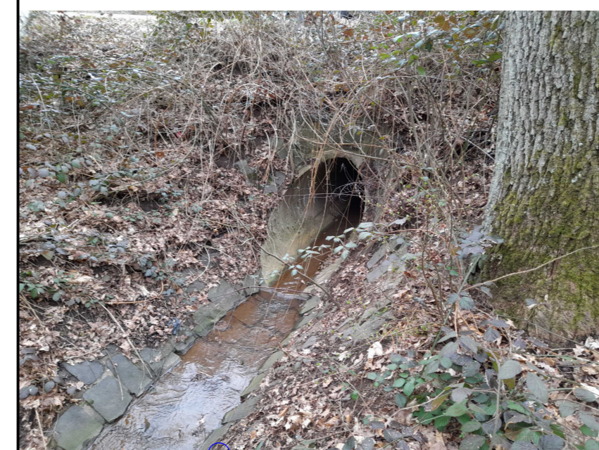
2.5.1.2.3 Durchlass unter Zufahrt US-Gelände DN1000
