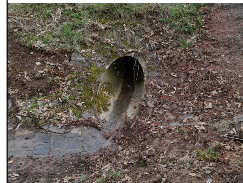
2.5.1.2.1 Durchlass Langwiedener Straße DN1000 Einlauf
