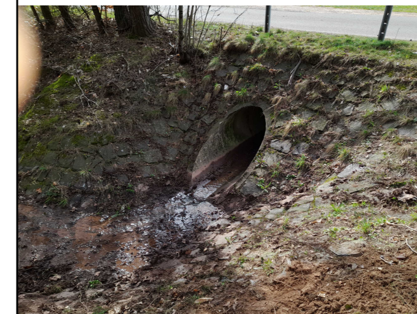
Durchlass Langwiedener Straße DN1000 Auslauf
