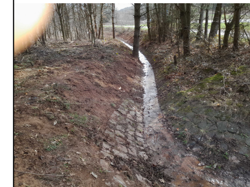
2.5.1.1.2 Weiterführender Graben nach Durchlass
